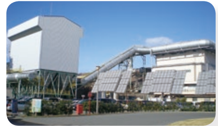
知多工場150トン電気炉の新集じん装置
